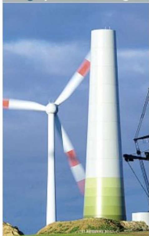
Una torre per pala eolica in costruzione in Germania
