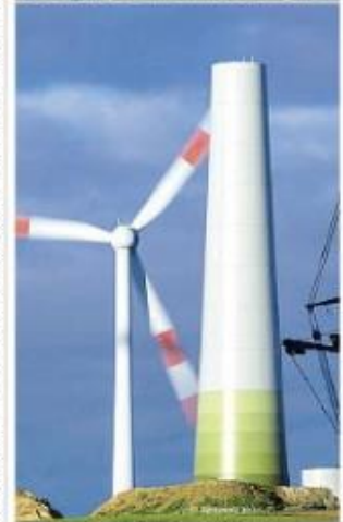
Una torre per pala eolica in costruzione in Germania
